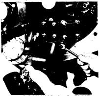
A -LOOSENING A-C PUMP FLANGE NUTS
